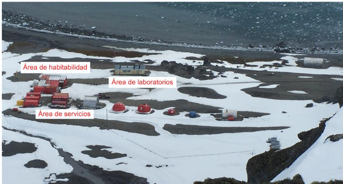
Figura 3 Imagen general de las instalaciones de la BAE Juan Carlos I
