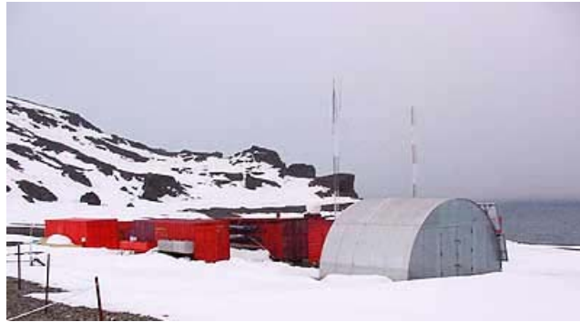
Figura 9 Módulos de Servicios
