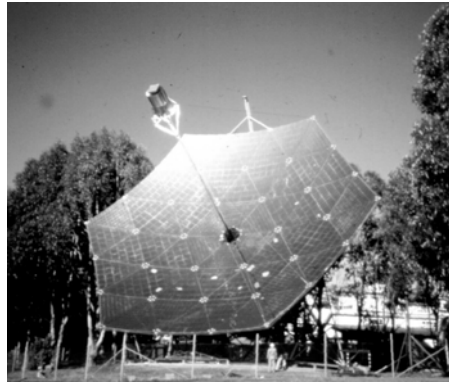
Figura 1.5. Disco concentrador hexagonal de 400 m 2 formado por paneles reflectores triangulares y sistema hidráulico de elevación (Australian National University)
